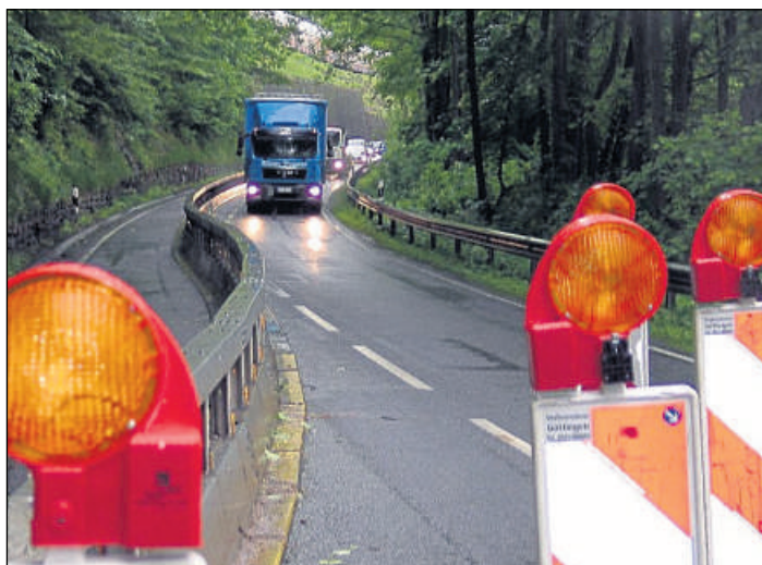
Die Gefahrenstelle: Seit Freitag sichern Notleitplanken die Fahrbahn vor Geröll. Der Verkehr wird einspurig vorbeigeführt. Foto: Maas
